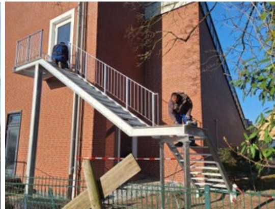
Neue Fluchttreppe für den Kantoreiraum
