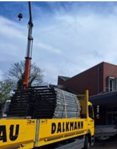
Das obere Dach wurde gedämmt.
